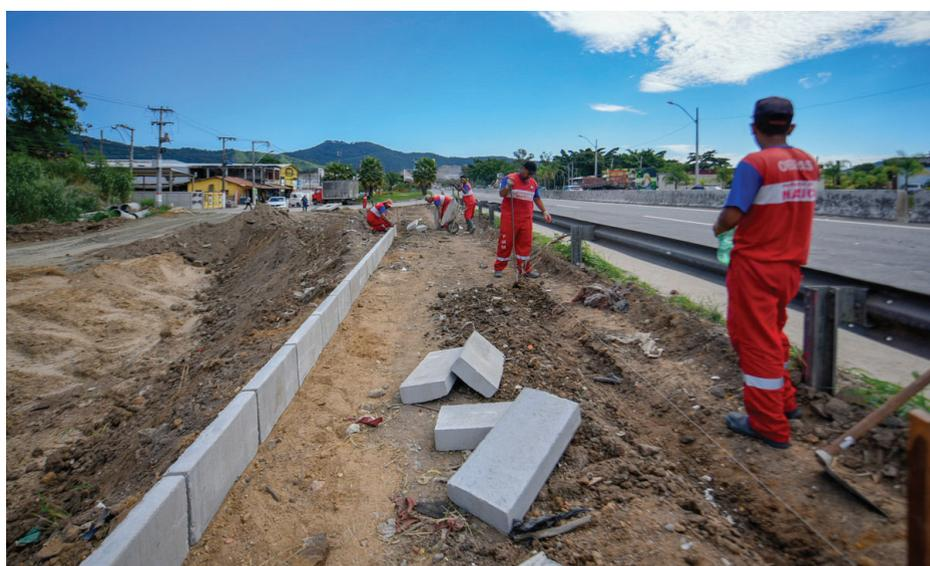
Pouco mais de um mês após a instalação da nova passagem de pedestres junto à rodovia RJ-106, em Inoã, o acesso para a via sobre o rio Roncador no sentido Maricá começa a ser preparado. Operários da Prefeitura trabalham na montagem das peças de meio-fio junto à grade de proteção no mesmo nível da pista para, em seguida, concretarem o leito da calçada.
