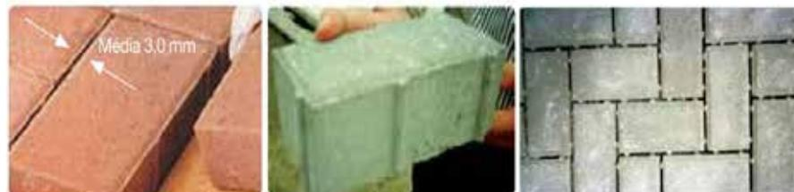
Junta entre blocos – média 3 mm    Blocos com separadores    Assentamento de blocos com separadores
