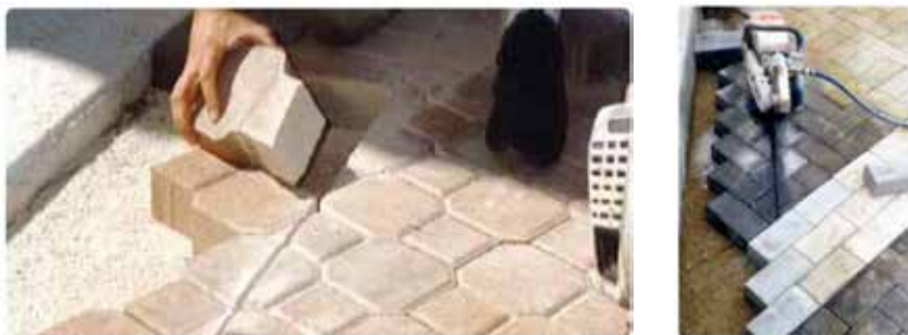
Figura 86: Corte do bloco no piso
