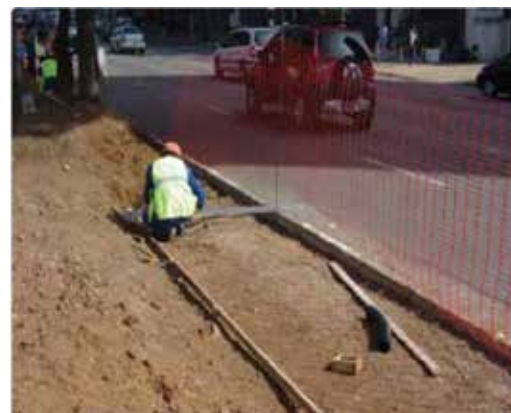
Figura 97: Preparação da sub-base
