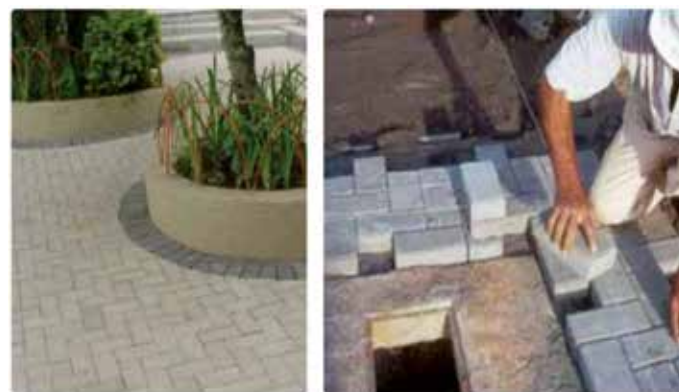
Figura 87: Acabamento junto ao confinamento interno
