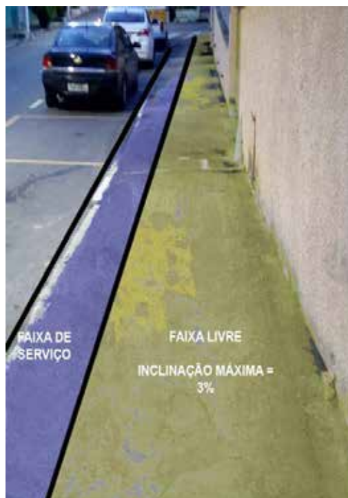
Figura 8: Indicação das faixas em uma calçada em declive
