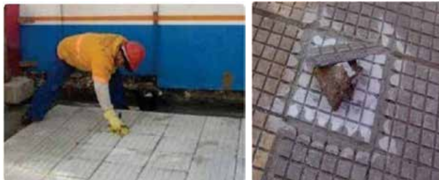
Limpeza do ladrilho hidráulico
