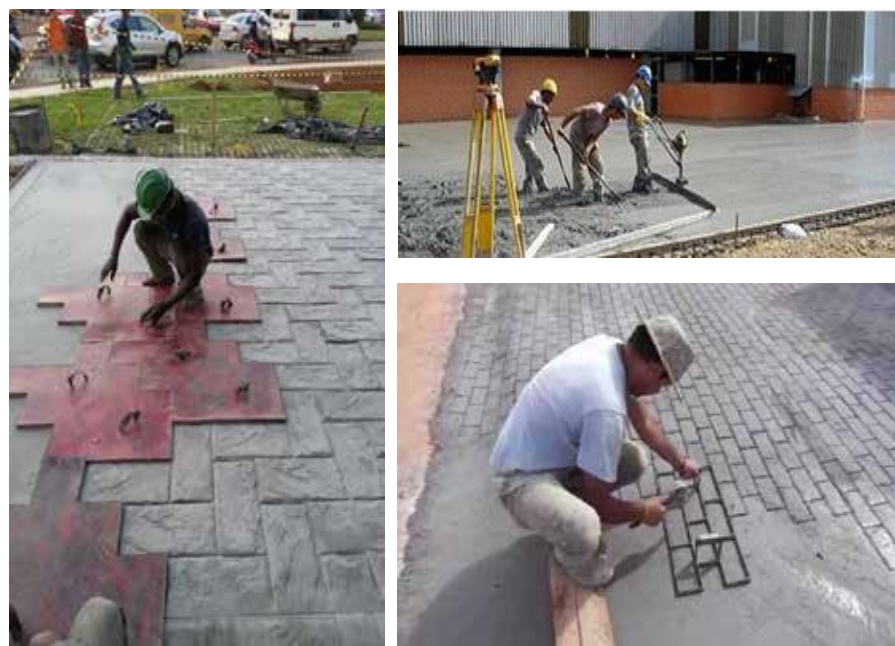
Figura 109: Execução de concreto estampado:
