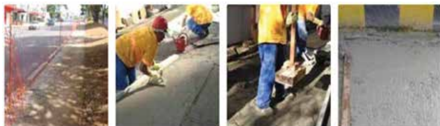
Figura 99: Etapas de execução da base
