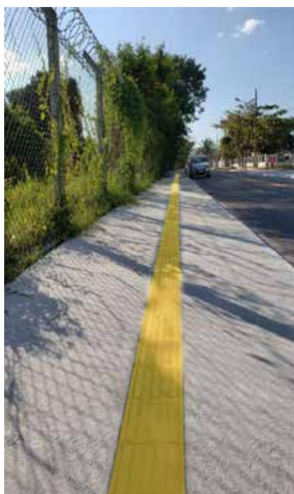
Figura 4: Calçada de 1,50 m localizada em Araçatiba - Acesso ao aeroporto
