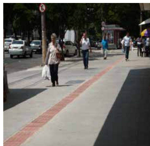
Figura 107: Concreto convencional moldado in loco.
