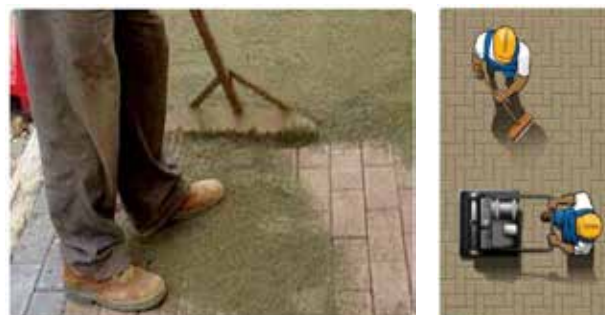
Figura 91: Selagem do pavimento até a sua compactação
