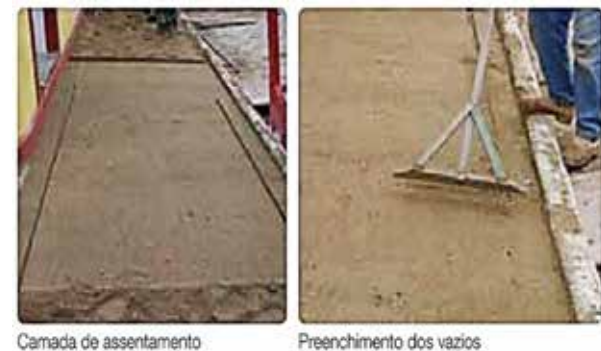
Figura 79: Camada de assentamento e preenchimento dos vazios
