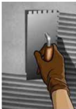
Figura 102: Etapas de execução com argamassa industrializada:
