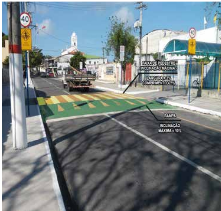
Figura 32: Dimensões máximas da faixa de travessia elevada
