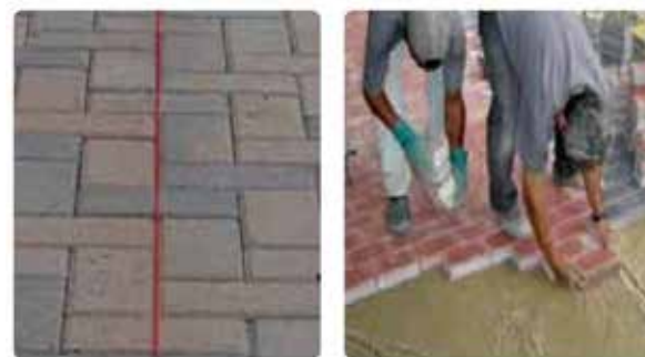
Figura 83: Alinhamento para assentamento dos blocos
