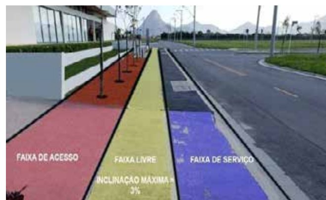
Figura 6: Indicação das faixas de uma calçada (no Condomínio Alphaville – Inoã)
