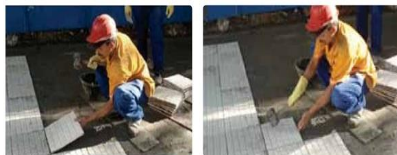
3º Colocação do ladrilho hidráulico
