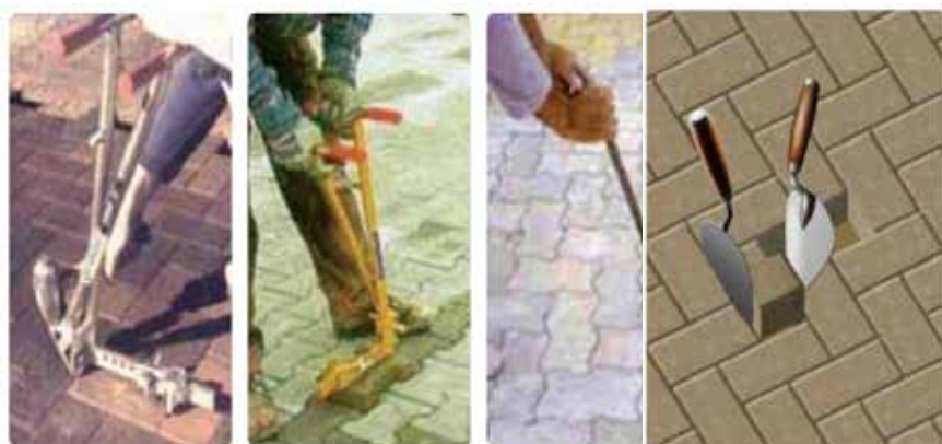
Figura 89: Retirada de blocos danificados
