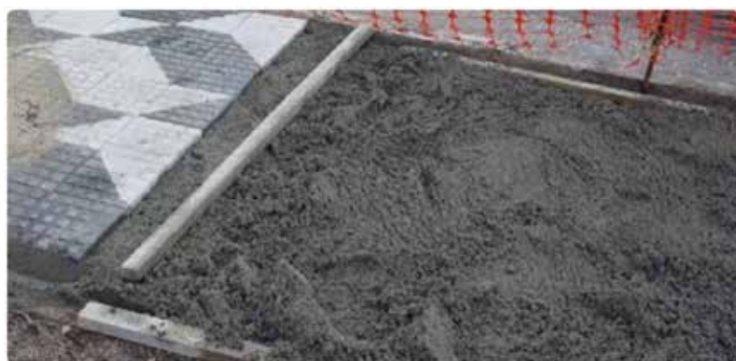
Assentamento utilizando argamassa tradicional
