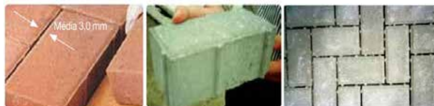
Figura 82: Detalhes dos blocos com separadores
