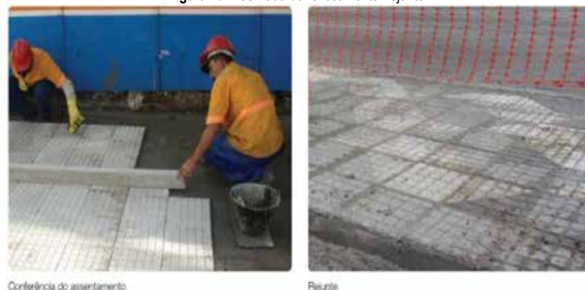
Figura 104: Camada de revestimento–rejunte
