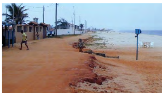
Erosão do topo do cordão da Praia de Itaipuaçu
