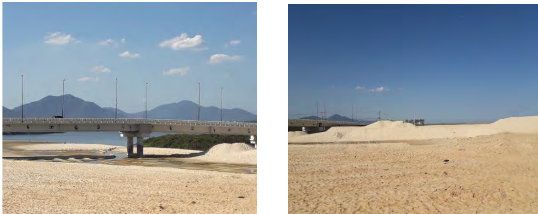
(14) Construção da Ponte 'Barra Seca', finalizada. A ligação da lagoa com o mar ainda não. Fonte: IBAM, 2020.
