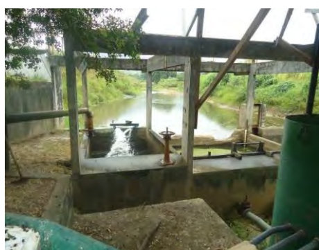
(c) Captação da CEDAE - vista para montante
