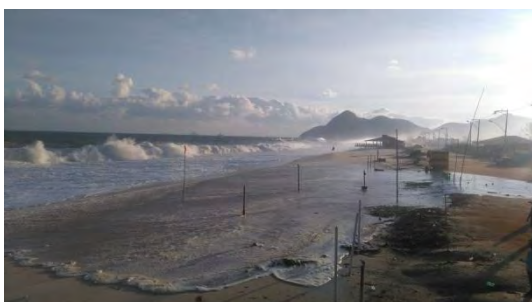
Invasão pelo mar da Av. Beira Mar em Itaipuaçu (06/2016)
