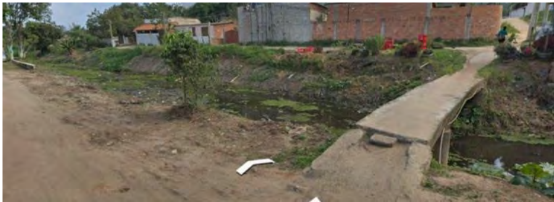
(10) Lançamento de esgotos in natura. Não foram observados lançamento de esgotos no trecho do canal próximo ao deságue no mar. Foram observadas redes de drenagem implantadas e em construção. Fonte: IBAM, 2020.
