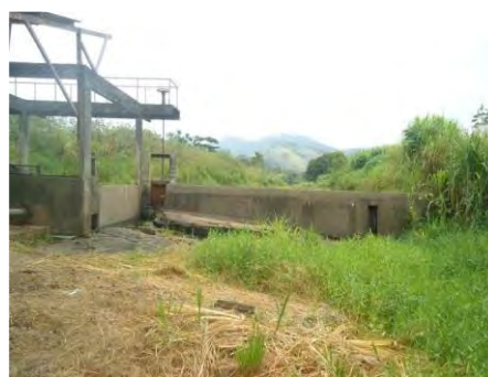
(d) Captação da CEDAE - vista para jusante
