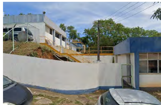
(b) ETA Maricá - vista lateral
