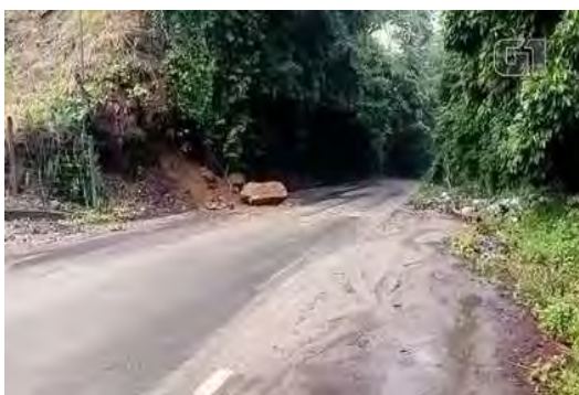
Deslizamento de barranco na RJ 106
