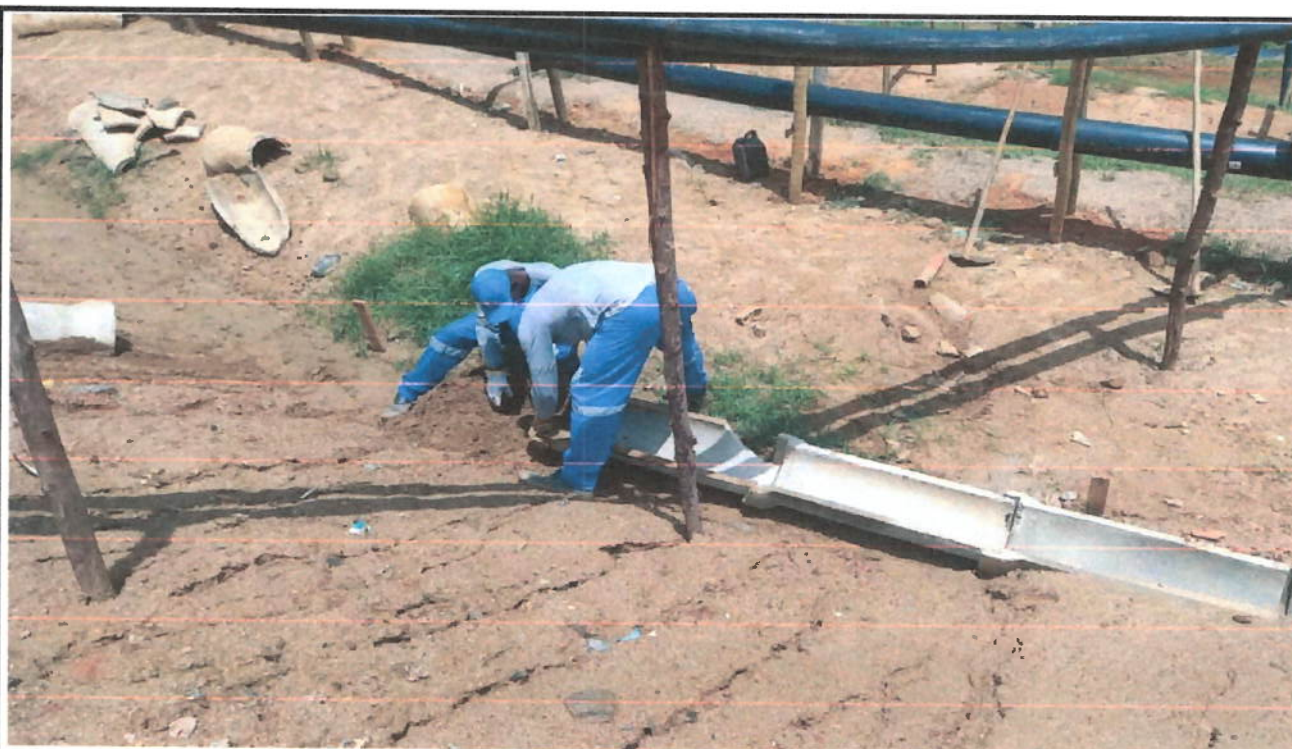
Aplicação de canaletas de drenagem superficial para águas pluviais.
