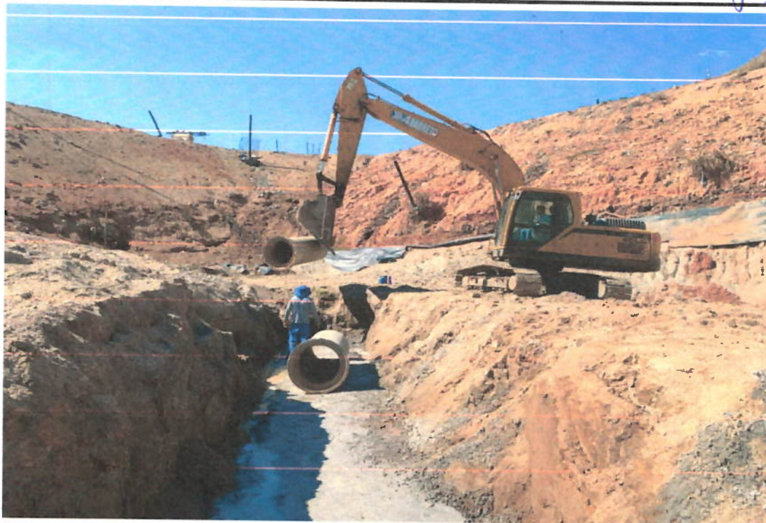
Drenagem Sub-superficial - Drenagem por baixo da área protegida com geomembrana.
