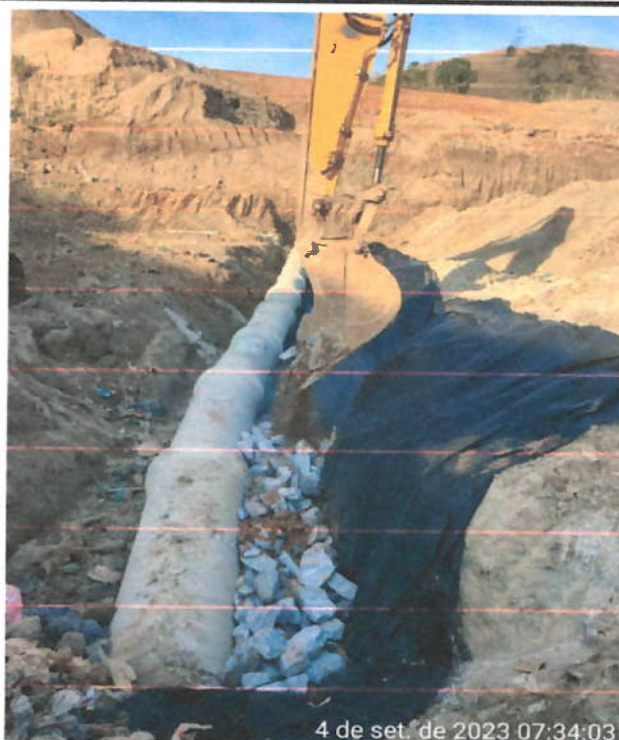
Drenagem Sub-superficial - Drenagem por baixo da área protegida com geomembrana.
