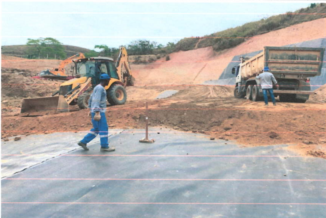
Proteção Mecânica com material de solo sobre a Geomembrana.
