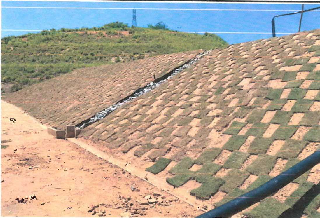
Cobertura vegetal sobre os taludes para estabilidade e combate a erosão.
