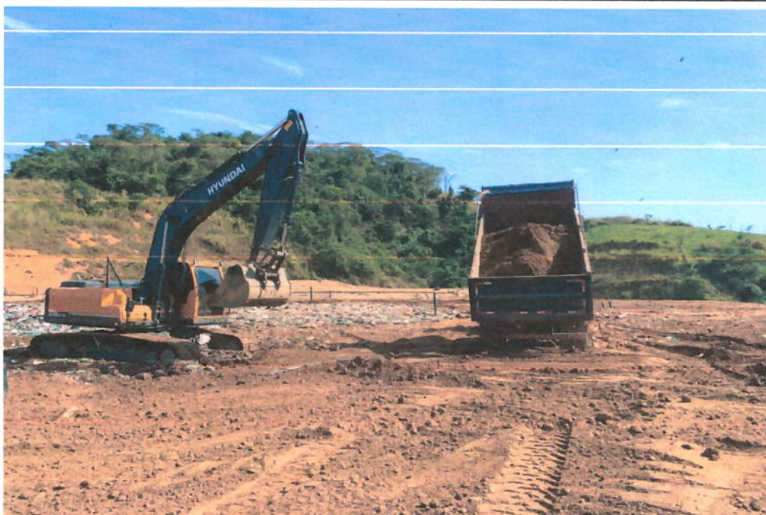
Recobrimento dos resíduos com material de solo.
