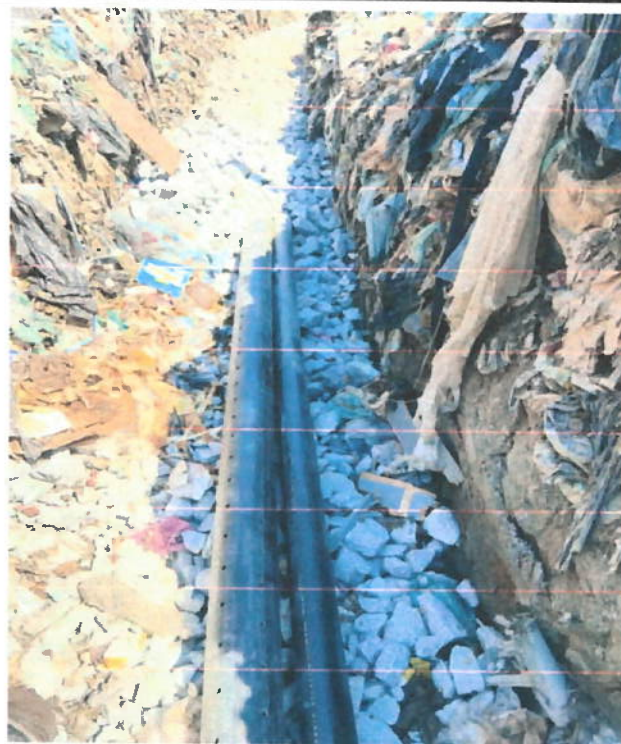
Aplicação de tubulação para captação do biogás.
