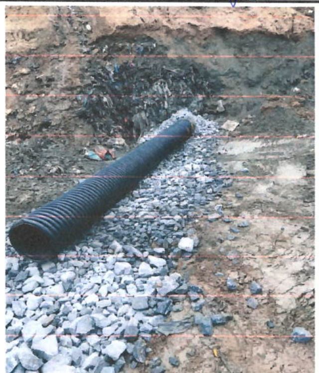
Drenagem de Base - Ampliação da área e interligação com a drenagem existente unificando o sistema
