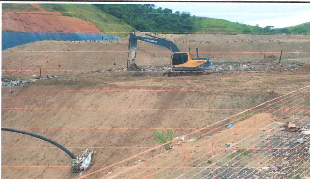
Recobrimento dos resíduos com material de solo.
