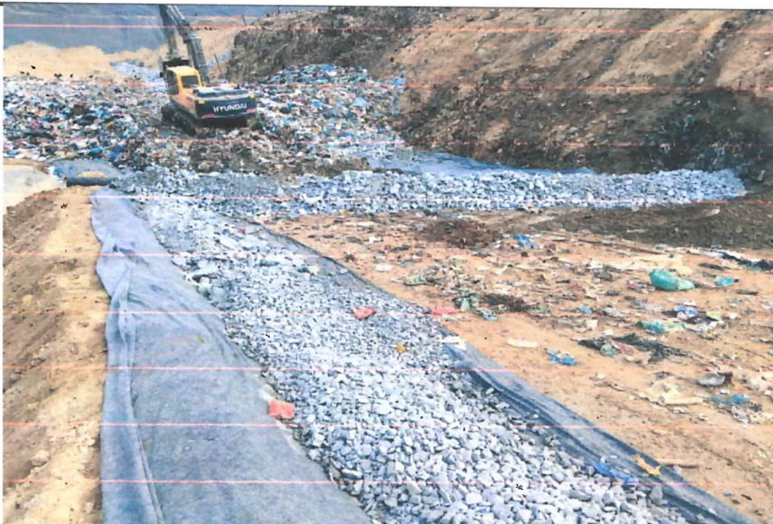
Drenagem de Base e sendo coberta com o lixo para início da operação de disposição.
