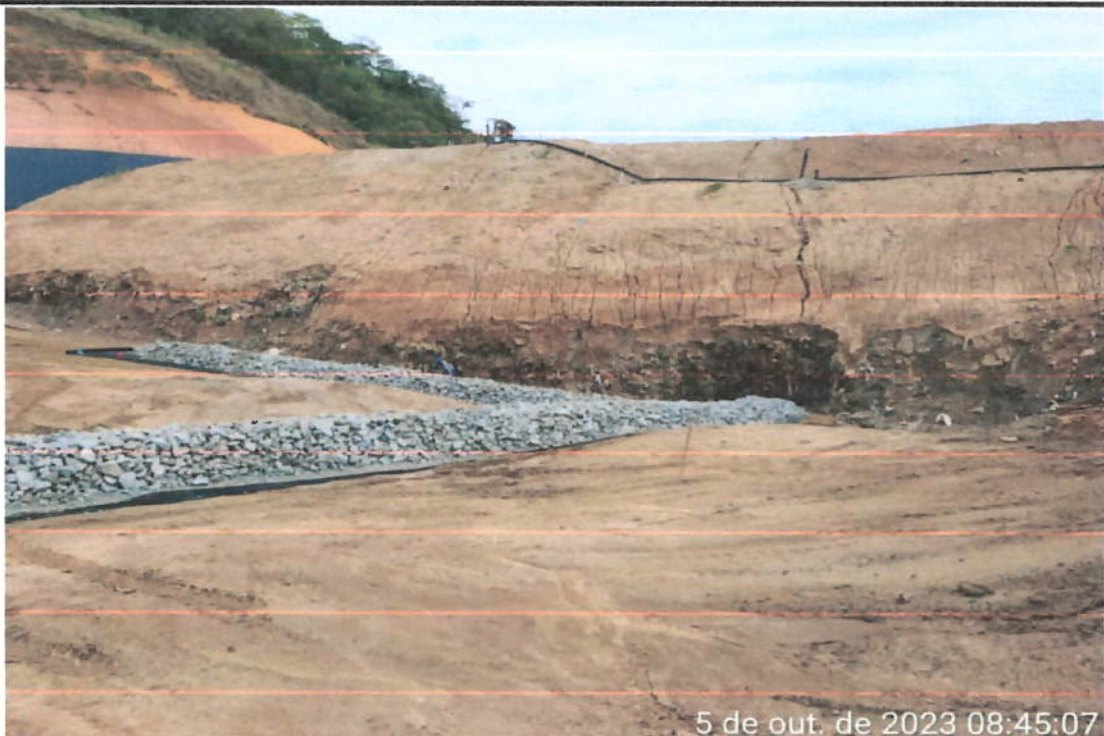
Drenagem de Base - Ampliação da área e interligação com a drenagem existente unificando o sistema
