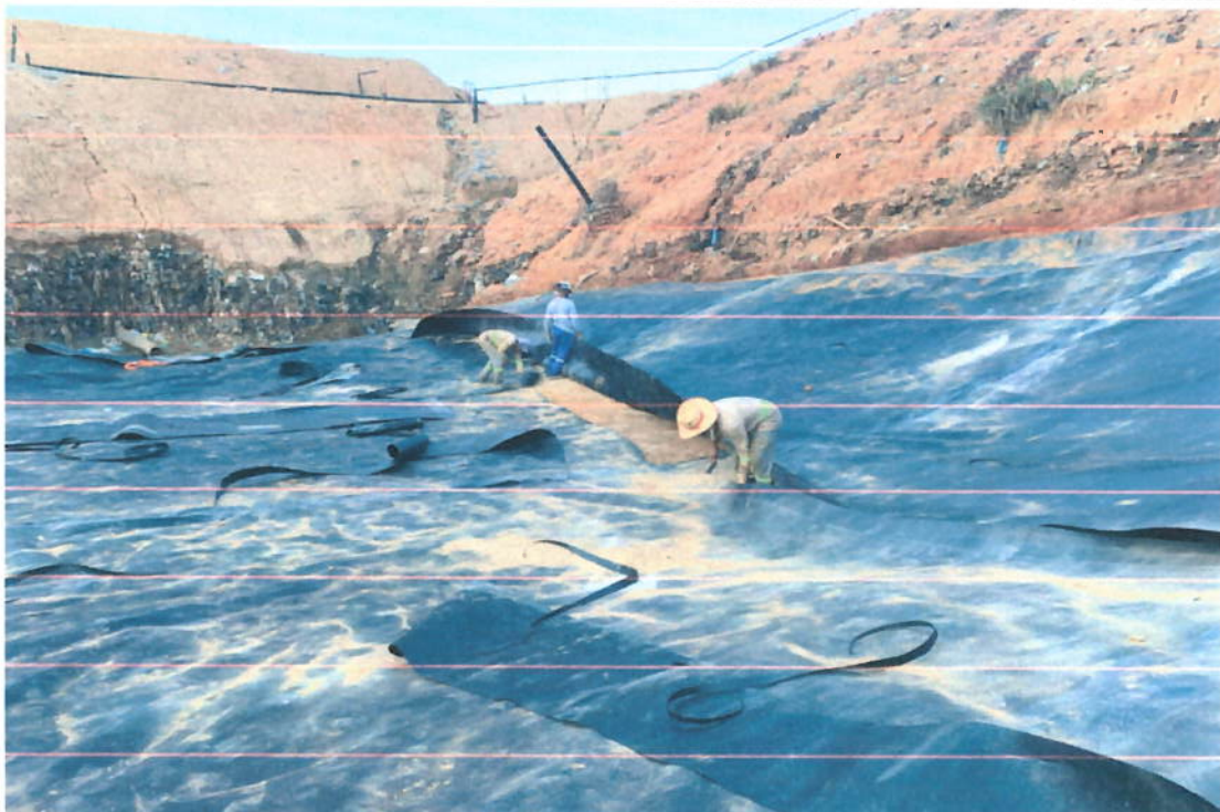
Aplicação de Geomembrana para proteção do solo.
