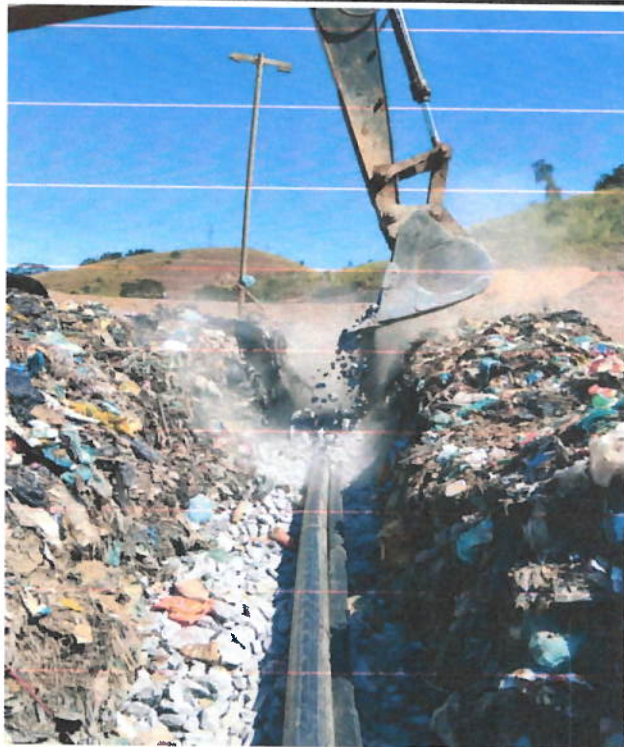
Aplicação de tubulação para captação do biogás.
