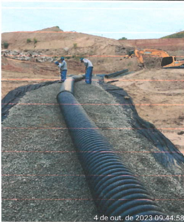
Drenagem de Base - Ampliação da área e interligação com a drenagem existente unificando o sistema
